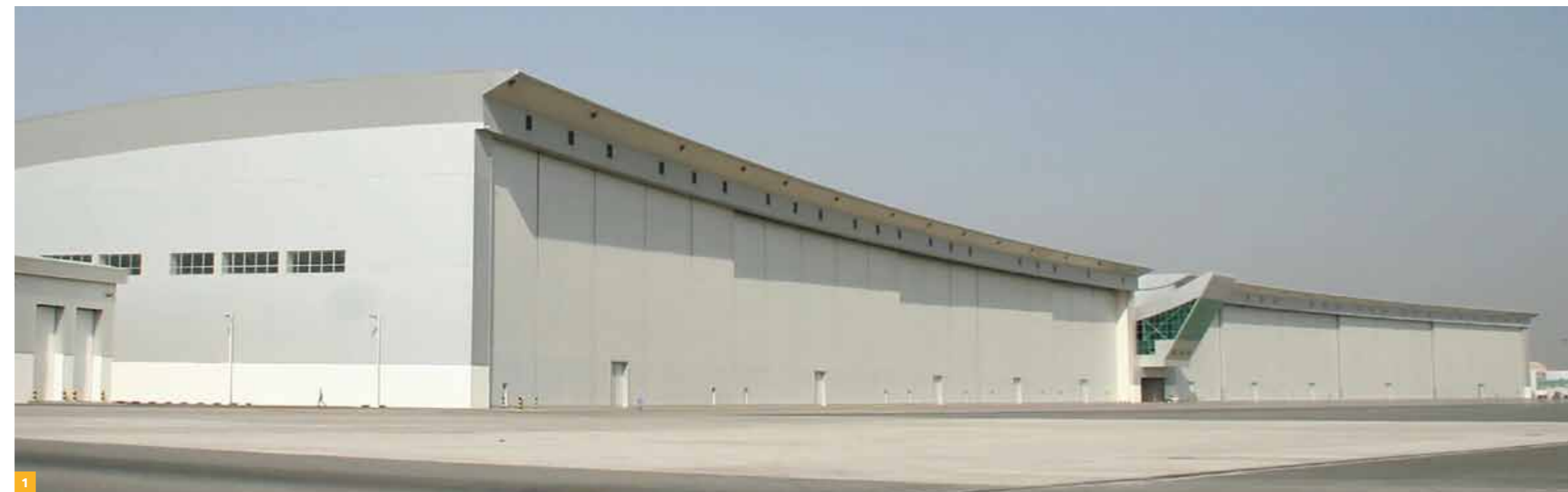
1 : Le Dubai Airwing – l'un des plus gros hangars au monde – dans l'aéroport international de Dubaï. Ses huit travées d'aéronefs sont équipées de portes coulissantes Esavian de Type 126, ce qui représente une largeur de 584m sur une hauteur de 25,85 m. Ces portes coulissent sur un rayon de 1,3 km qui correspond à la courbure de ce hangar.
